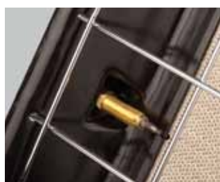
Защитная термопара для контроля пламени
