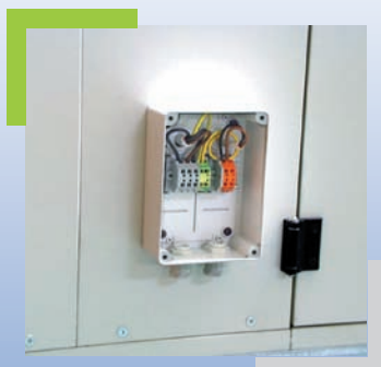
электроподключения выведены на специальный щит
