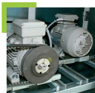
резервный вентилятор с автоматическим запуском
