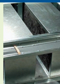
Внутреннее шумопоглощение шумоглушителя
