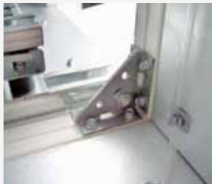
■ соединение секций
